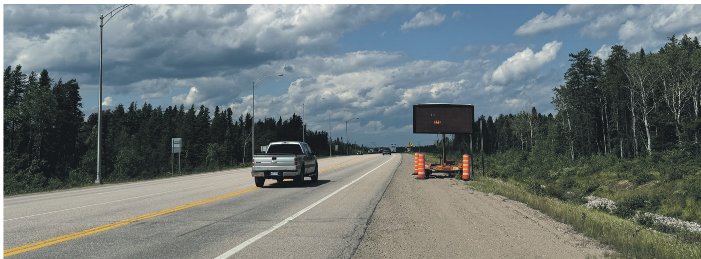
Un nouveau panneau a été ajouté à l'entrée est des travaux à Portneuf-sur-Mer. Photo Shirley Kennedy
